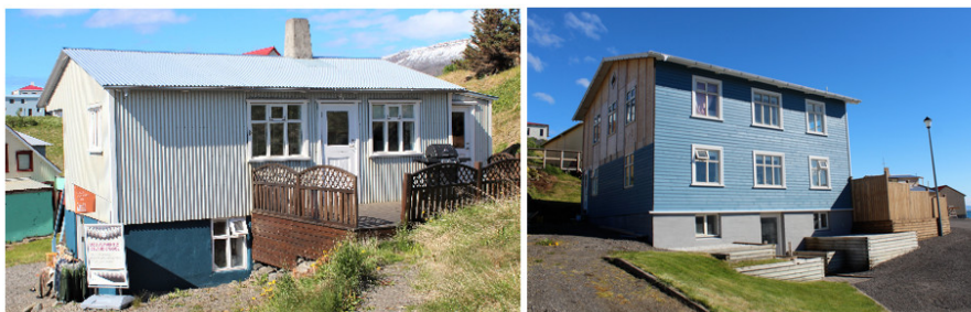
Mynd 26. Ás byggt 1923 og Baldurshagi byggt 1921. Ljós. SFA 2018.
