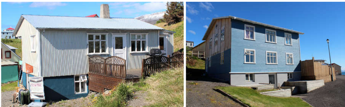
Mynd 23. Ás byggt 1923 og Baldurshagi byggt 1921. Ljós. SFA 2018.
