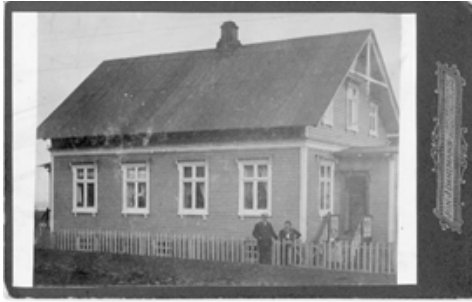
Húsið stuttu eftir byggingu - Mynd úr safni HSK
